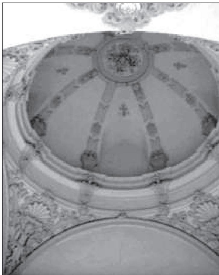
Cúpula de la antigua capilla del Sagrario.
